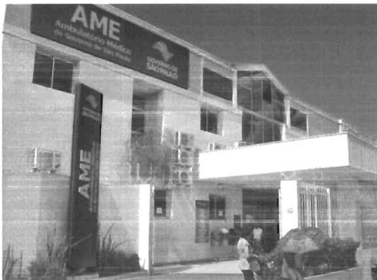
Unidade deve ser instalada em prédio a ser construído ao lado do AME que já atende em Araçatuba (Foto: Divulgação)
